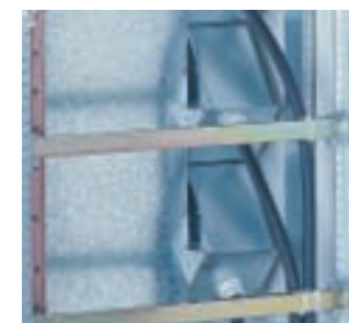
отсек кабельного подключения сзади с коробом на каждую функциональную единицу, внутреннее разделение до формы 4 тип 7
